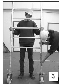
**2** - Mettre en place sous le premier barreau de l'échelle 2 longerons (photo 4 et 5). Attention positionnez les à l'oeil le plus perpendiculairement possible, serrez les, mais sans les bloquer. Répéter cette opération sur l'autre échelle à l'autre extrémité.
