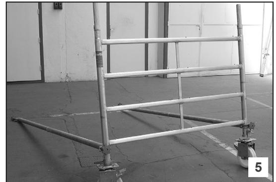
3 - Vérifier la bonne perpendicularité en mesurant la diagonale au mètre (photo 6) la cote doit être identique dans les deux sens (3,85 m). Dès le réglage terminé, bloquer définitivement les écrous des longerons. Vérifier et corriger si nécessaire la mise à niveau de la base (photo 7) en jouant sur le réglage des vérins. Dès le réglage terminé, bloquer chaque vis papillon des vérins sur l'échelle (photo 8).
