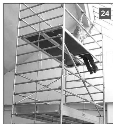
9 - Pour le montage d'un plancher à une hauteur supérieure à 2 m du sol (Attention hauteur maximum du sol : 3,40 m - photo 25) et supérieure à 2 m du plancher inférieur (Attention hauteur maximum du plancher inférieure : 3,00 m - photo 25), monter le plancher barreau par barreau en vous crochant à l'échelle (photo 26) après avoir installé des lisses de protections provisoires (voir photo 25, page 6, Aluxis 80).
