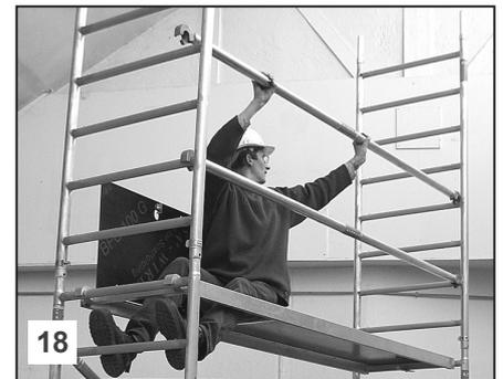
8 - Accéder au plancher et mettre en place les diagonales du niveau supérieur en procédant de la même façon qu'au point 3 (photo 6 et 19).
